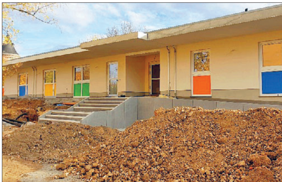
Noch wird fleißig am neuen Kinderhaus gebaut, aber eine Neuanmeldung über „Little Bird“ ist schon möglich. Foto: Manja Buhse
